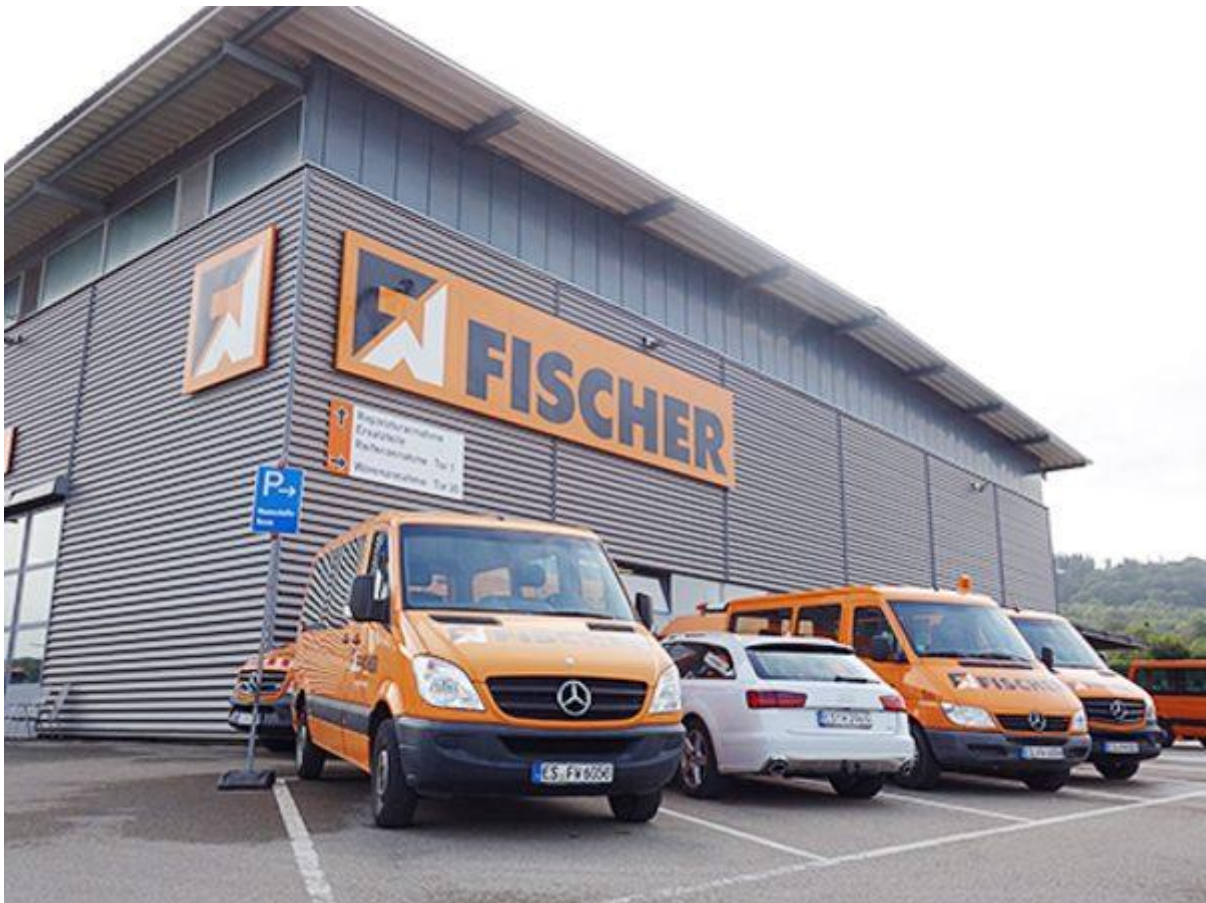
Das Firmengebäude der Firma Fischer Weilheim GmbH mit dem ServiceCenter in Weilheim a. d. Teck.
